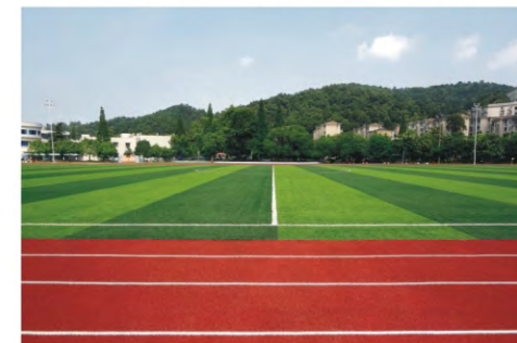
湖南南方科技项目 施工时间：2011年
